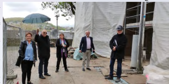
Mit Geld des Bundes kommt die Sanierung der historischen Martini-Kirche in Siegen voran. Jetzt konnte sich Volkmars Klein vor Ort vom Fortgang der Arbeit überzeugen. Mit dabei auch Patricia Lips MdB, die im Haushaltsausschuss des Deutschen Bundestages die verantwortliche Berichterstatterin für Denkmalpflege und für Kultur ist.
