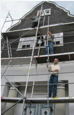
Praktischer Einsatz für die Kirche: Volkmar Klein packt mit an beim Gerüstaufbau am Konfirmandenhaus in Burbach.
